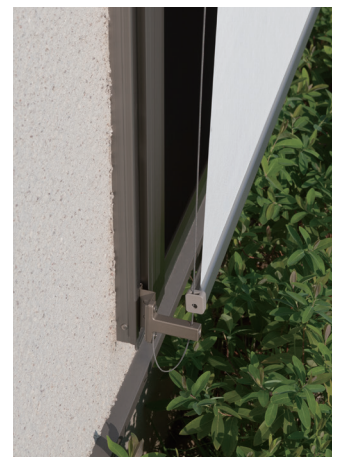
サッシ取付け時 下部アップ
